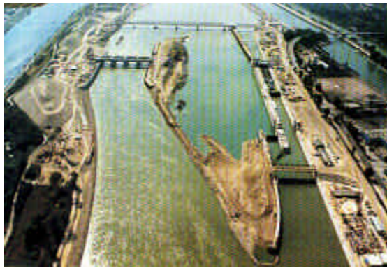
Bild 1: Donaukraftwerk Freudenu/Wien im Bauzustand.
