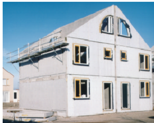
Abb. 1 Betonfertigteile im Hausbau
